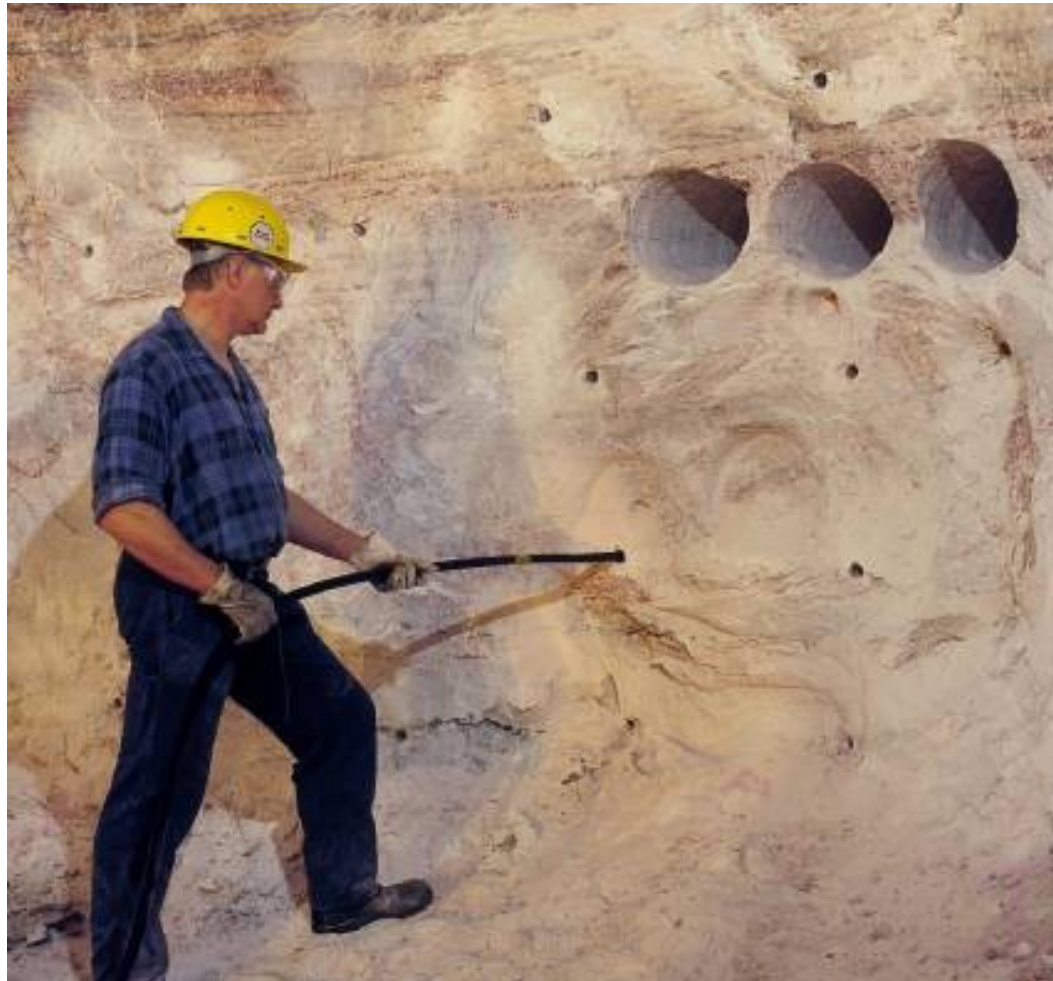
Einblasen des Sprengstoffs in die Sprengbohrlöcher
